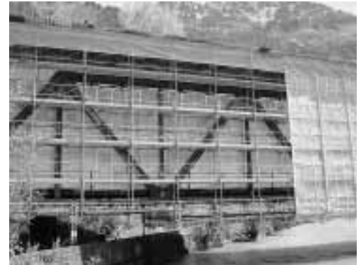
Bild 1: Gerüst, bei dem gerade eine Einhausung aufgebaut wird.
